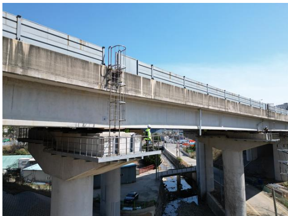
도보점검 및 드론활용 전경
